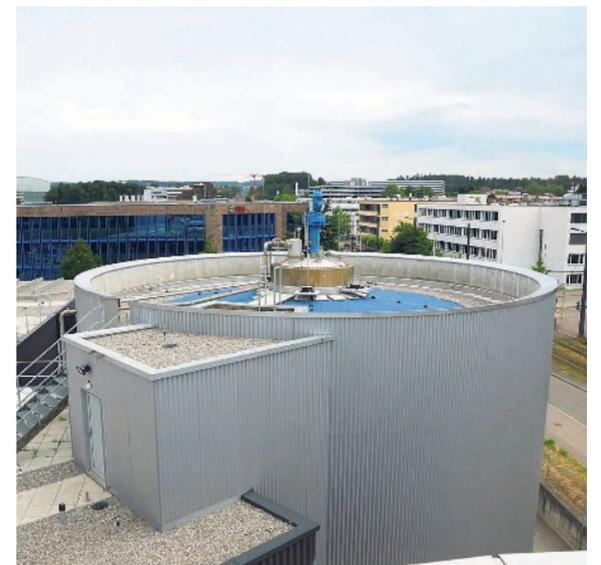
In den beiden Faultürmen entsteht Gas, das in Strom umgewandelt wird.
