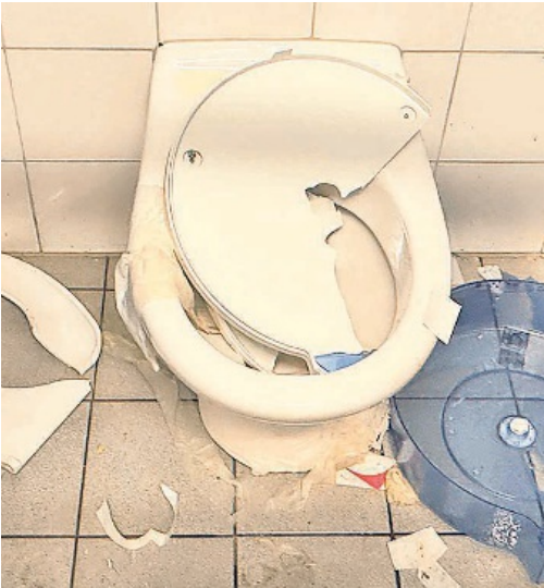
Einige Rapperswil-Fans haben beinahe alles auf der WC-Anlage im Gästesektor zerstört. BILD ZVG
