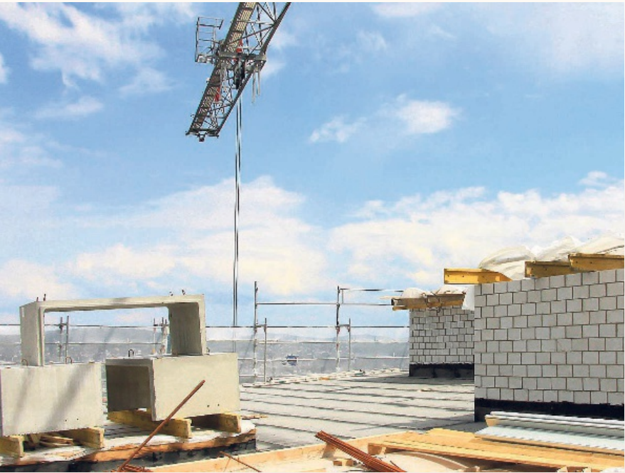
Das Thema Nachhaltigkeit ist auch auf der Baustelle angekommen. BILD LISA MAIRE Planung schaffen Bauprofis so Gebäude, die gute ökologische Standards besitzen und setzen. Jared Thomas
