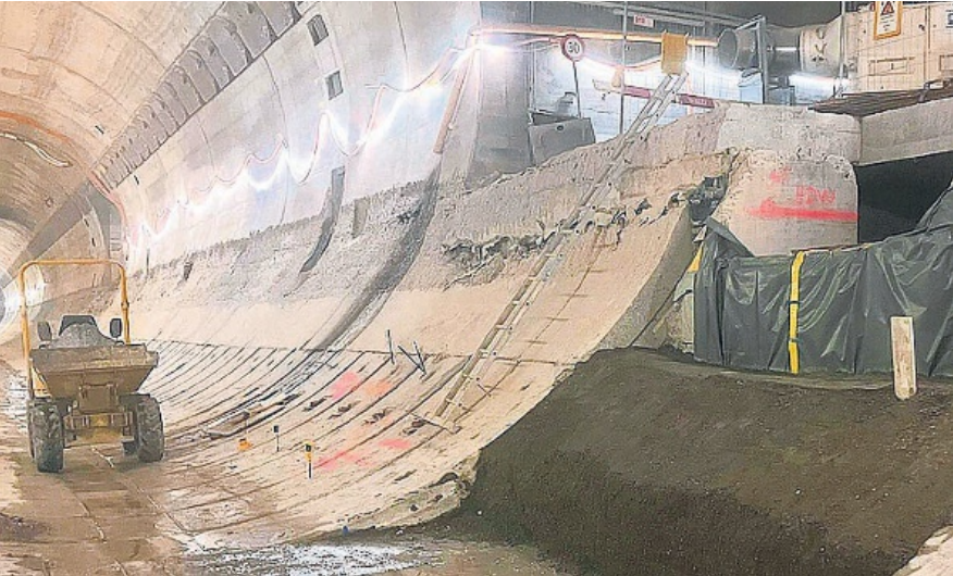
Auch eine Lüftungszentrale wird erstellt und installiert.
