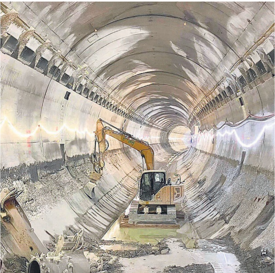
Bilder zeigen die Gubriströhre während der Sanierungsarbeiten. BILDER BUNDESAMT FÜR STRASSEN
