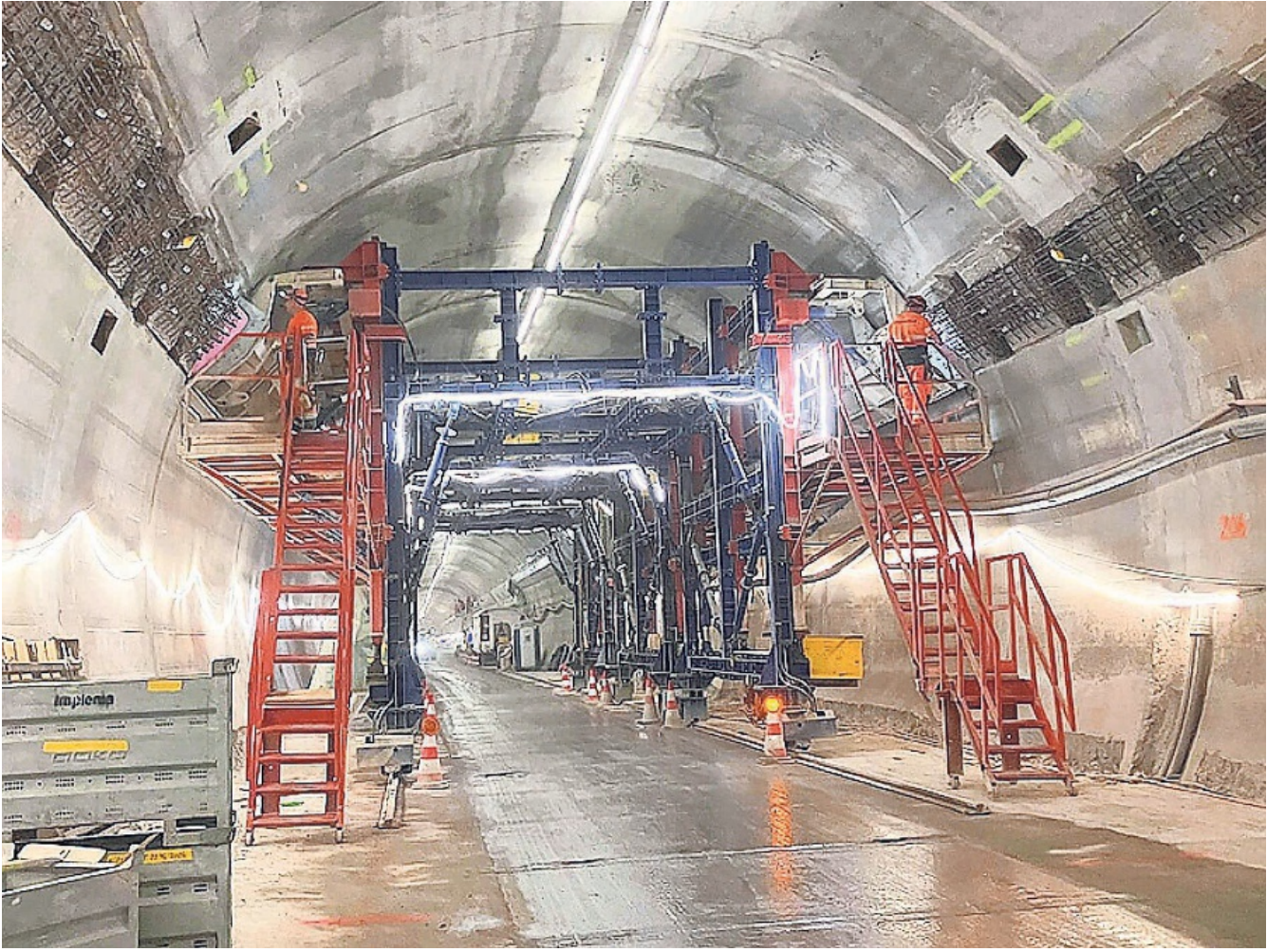
Mit einer Sohlbrücke werden derzeit Kanalelemente für Leitungen eingebaut. Sie sollen Wasser und Strom durch den Tunnel führen.
