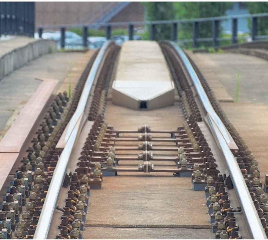
«Ausziehbare» Schienen lassen zu, dass diese sich bei Hitze dehnen.
