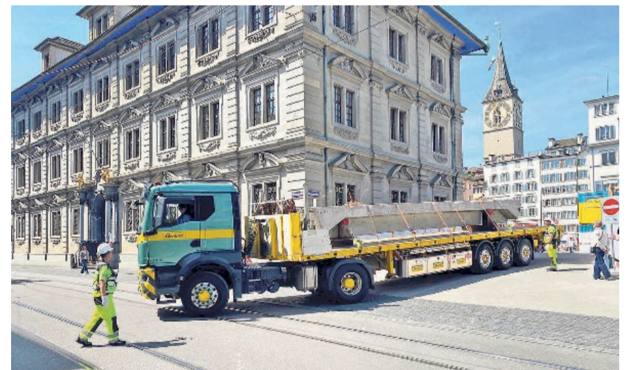
Mit solchen langen Lastwagen werden die Brückenstücke nach Rümlang transportiert.
