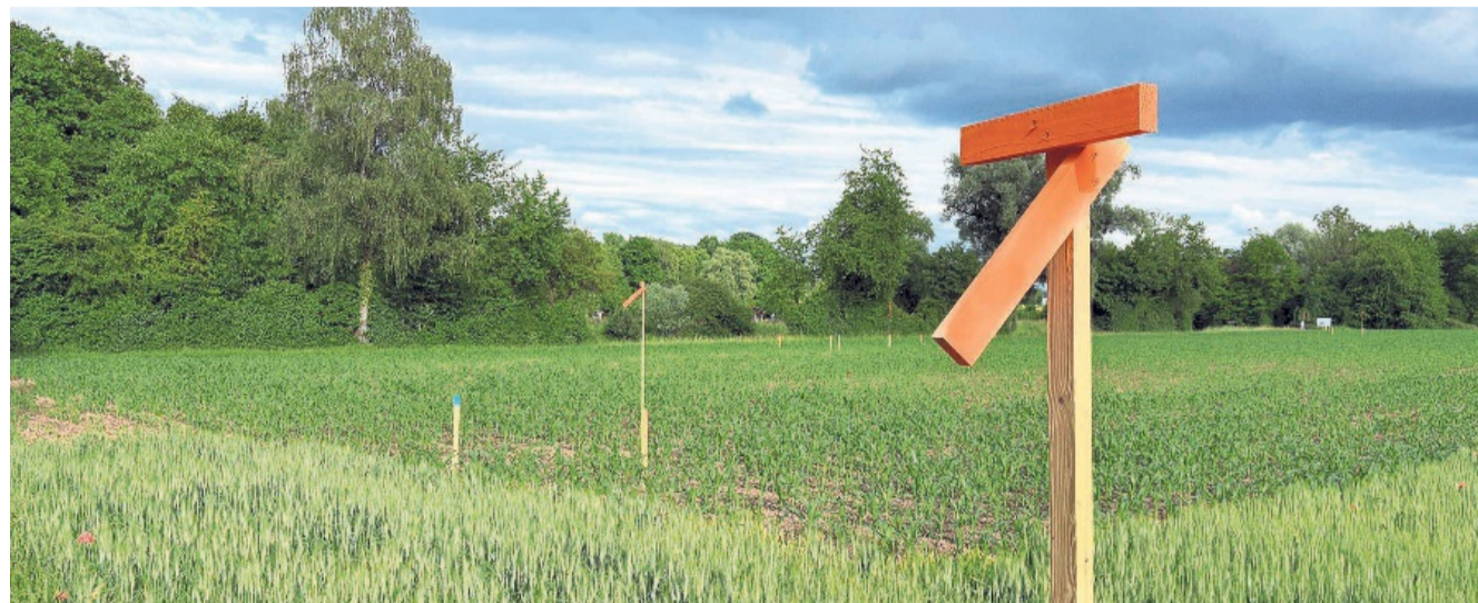
Bauprofile zeigen derzeit in Rümlang, wie die Glatt wegen der Pistenverlängerung verlegt werden muss.
