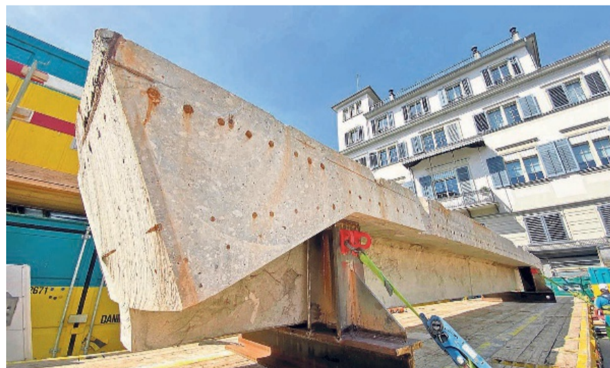
Die Betonteile sind gegen 19 Tonnen schwer.
