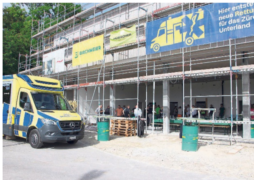
Auf dem Gelände der EKZ in Bülach Nord entstehen fünf Einstellplätze für Rettungsfahrzeuge, moderne Arbeits- und Aufenthaltsräume, Pikettzimmer sowie Schulungsräume.
