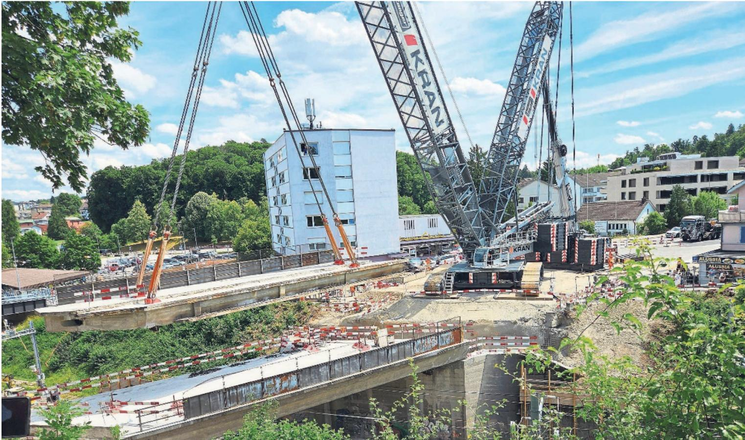
Endlich an den Haken: Das erste Teil der alten Strassenbrücke beim Kino Claudia wird abgehoben und auf den 28-rädrigen Tieflader (hinten rechts) abgesetzt.
