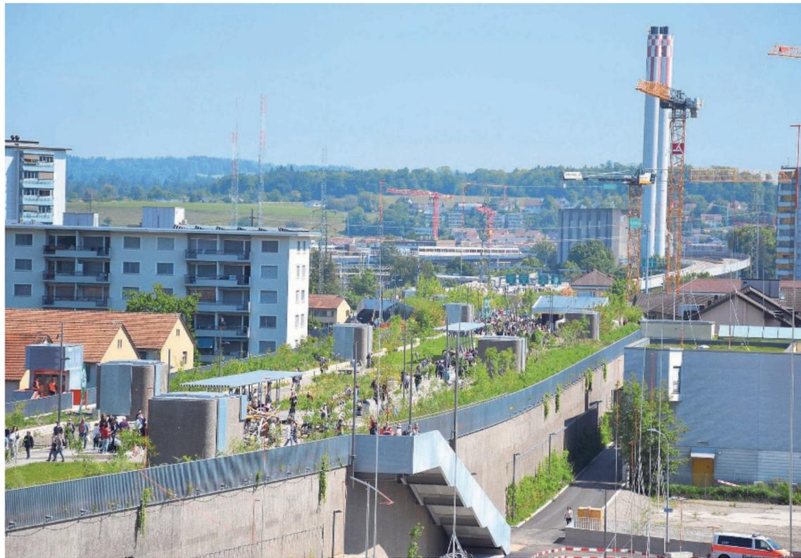
Lärmschutz mit Zusatznutzen: der Park auf dem Schwamendinger Autobahndeckel. Darunter rollt unhörbar der Verkehr.
