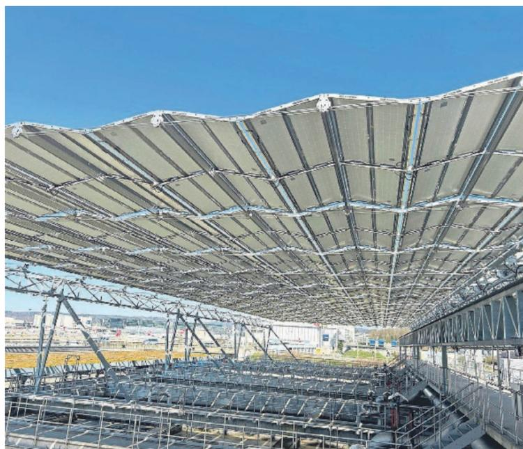
Bei Wind oder Schnee zieht sich das Faltdach zurück, um nicht beschädigt zu werden. BILD AKO
