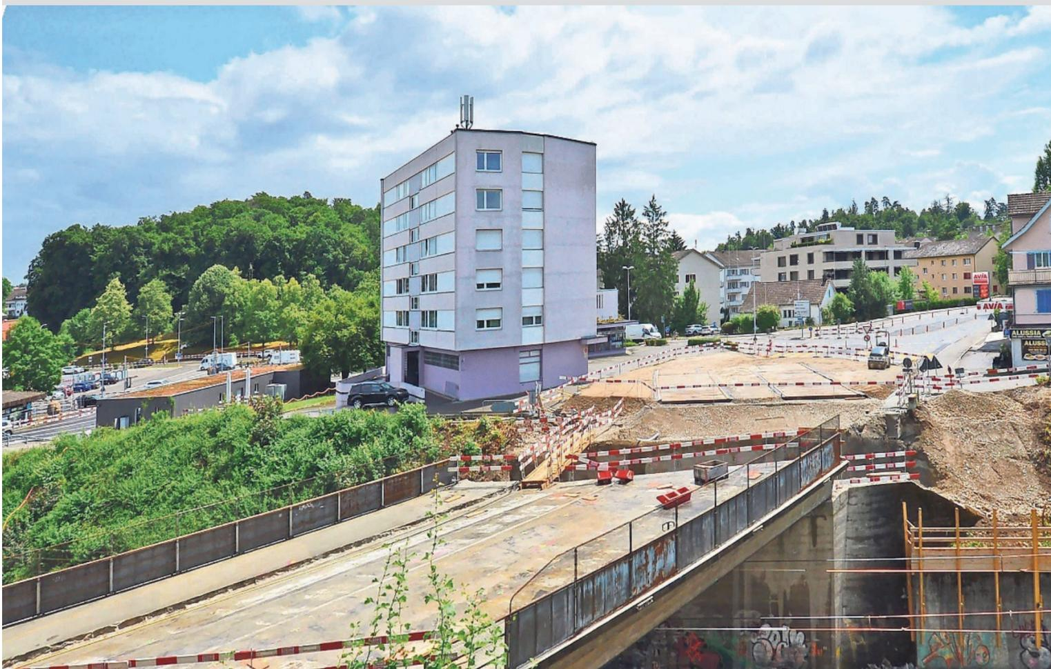
Die alte Strassenbrücke wird abgebrochen und ein breiterer Übergang gebaut. Im Hintergrund ist das vorbereitete Fundament für den Raupenkran zu sehen.
