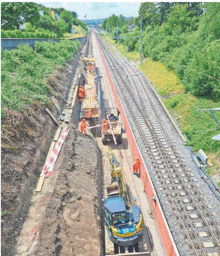
Damit die Züge künftig auf zwei Gleisen separat verkehren können, müssen ein breiteres Gleisbett und neue Stützmauern gebaut werden. Im Bild die auf ein Gleis verengende Bahnlinie.
