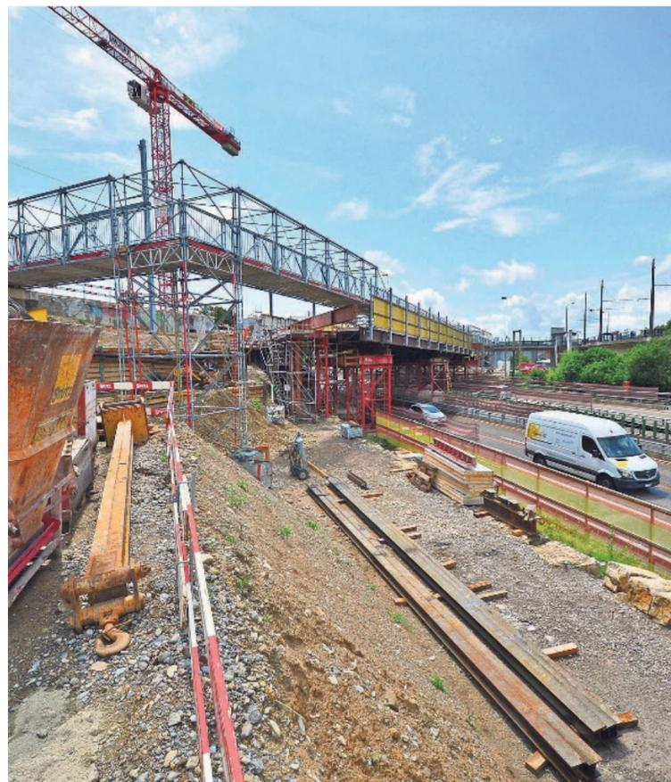
Mit dem Doppelspurausbau müssen auch alle Brücken angepasst werden. Derzeit wird die Autobahnbrücke über die A51 verbreitert, weshalb Spurverengungen nötig sind.
