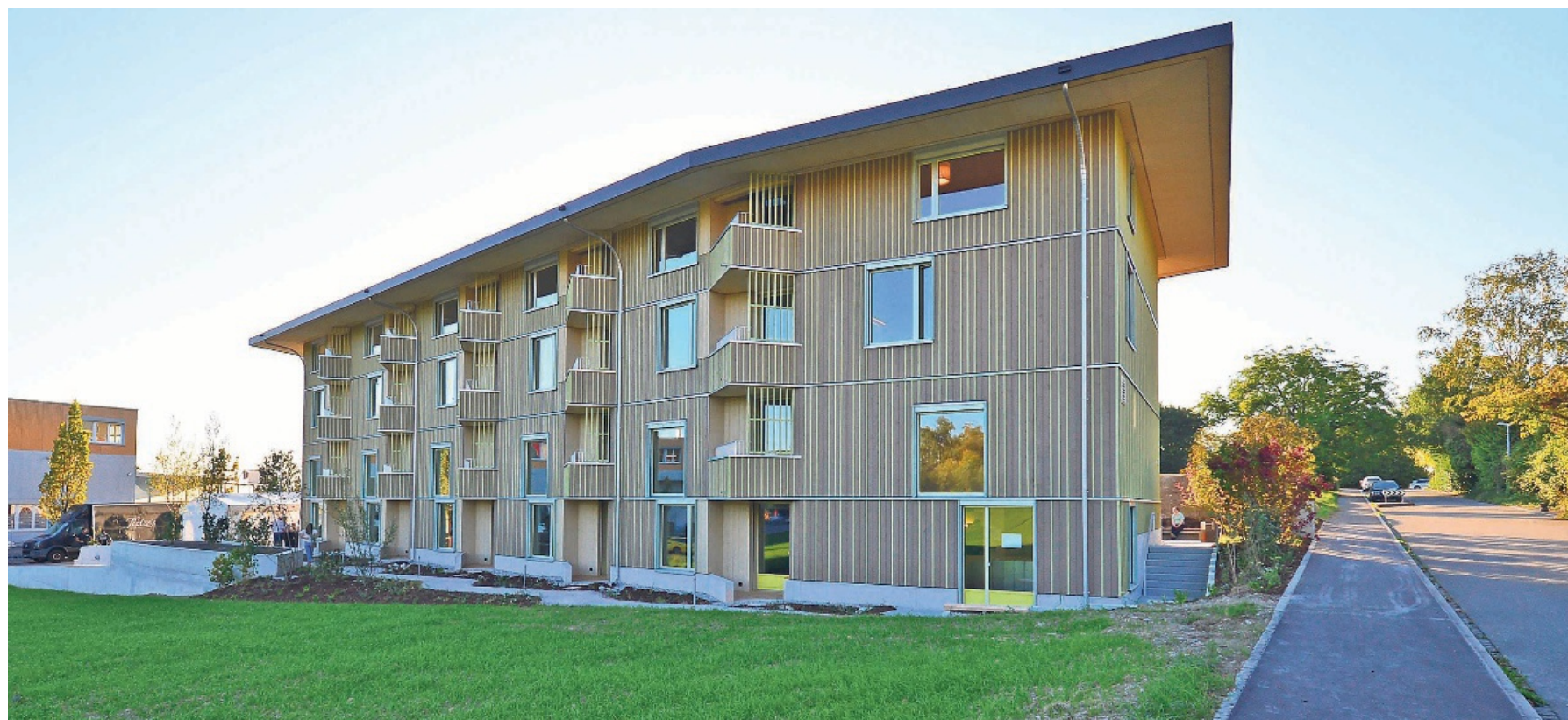
Der «Kibako»-Neubau zwischen Industrie und Einfamilienhäusern: Die Fassadenschalung mit vertikalen Deckleisten sorgt für eine lebendige Reliefwirkung und Schattenbildung.
