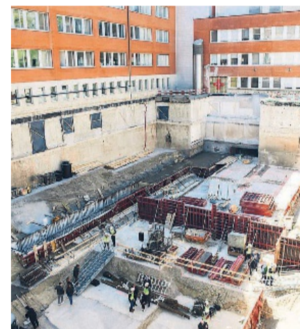
Die Baugrube ist 12 Meter tief.
