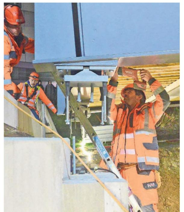
Mit der Sticksäge werden überstehende Holzteile abgesägt. Im Vordergrund eines der vier Brückenlager.
