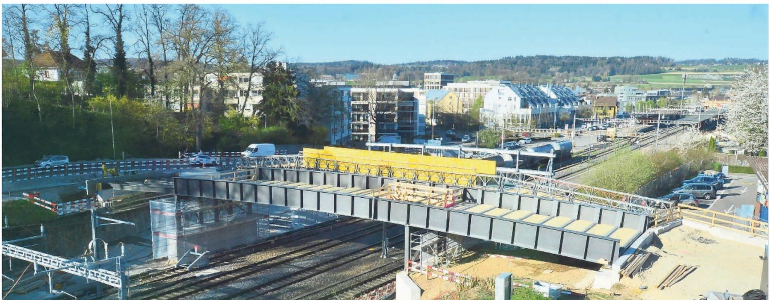
Am Tag danach: Im Vordergrund die Strassenhilfsbrücke, parallel dazu verläuft die Fussgängerhilfsbrücke (gelb). Die Fahrbahn der Strassenhilfsbrücke wird noch betoniert. Die knapp 100 Tonnen schwere, vorwiegend aus Stahl bestehende Brücke kann nicht mehr wiederverwendet werden und wird in gut zwei Jahren abgerissen.
