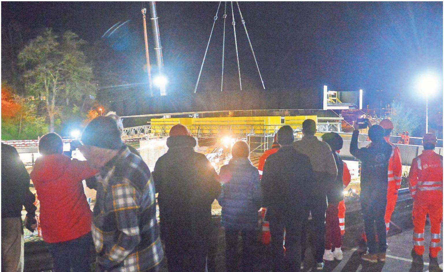
Verfolgt von zahlreichen Schaulustigen wird nach Mitternacht das zweite Teilstück der stählernen Strassenhilfsbrücke über die Gleise gehoben und auf die Stützen gesetzt.
