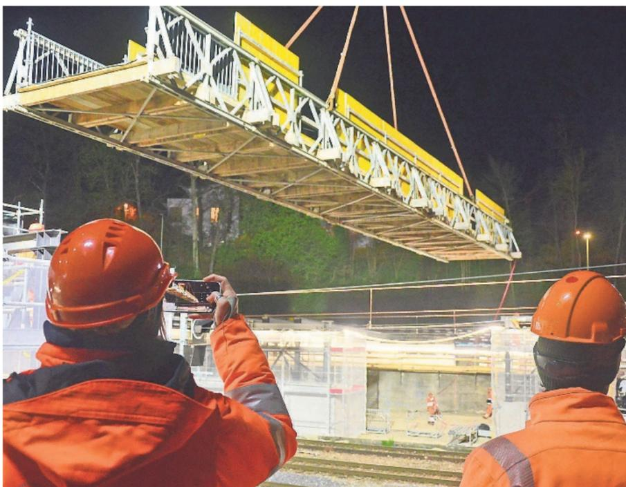
Auch für die Planer ein Spektakel, das festgehalten werden will: Die Fussgängerhilfsbrücke wird auf die Betonsockel gesetzt. Dabei handelt es sich um Elementbauten, die wiederverwendet werden können.
