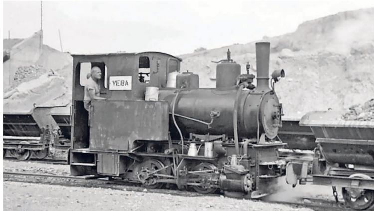
Die Lok der «Märkischen Lokomotivfabrik» aus dem Jahr 1898 transportierte beim Bau des Flughafens Kloten Kies vom Holberg in den Bereich der Panzerpisten.
